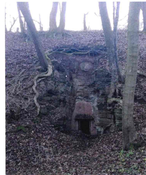
der verschlossene Stollen- eingang unterhalb der Bahn
