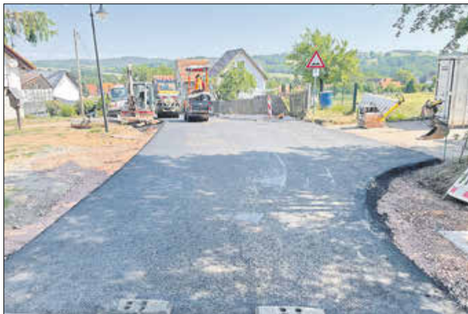
Herstellung der Straßenoberflächen in der Hagelgasse und in der Friedensteinstraße
