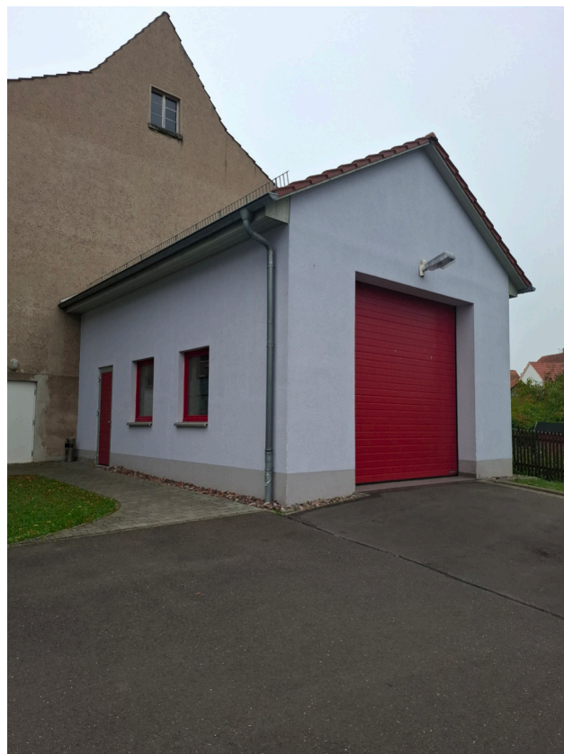
Abbildung 23: Feuerwehrgebäude Oberellen Quelle: eigenes Foto
