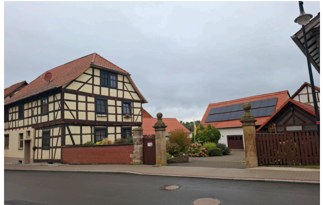
Abbildung 32: Historisches Fachwerkhaus in Oberellen
