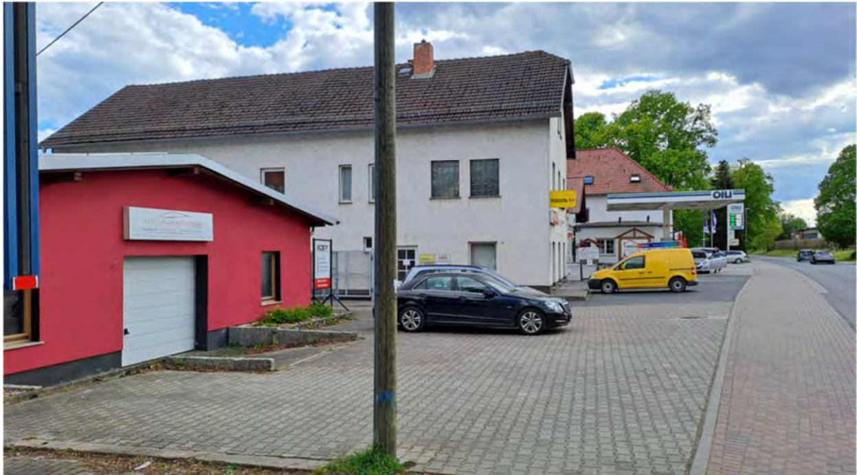
Abbildung: Fremdgewerbe (Tankstelle, Bauklempnerei, AuV-Autos) an der Landstraße 1-7
